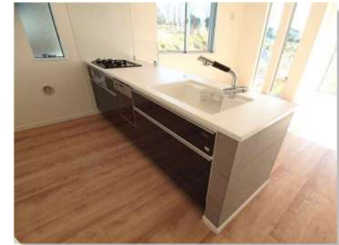
キッチンパネル LNU-2664CM 施工例
